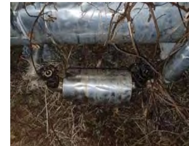
Plug Drain และ เกสียวใน ของ Steam Trap ขาด
