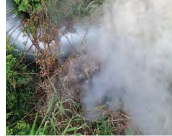
ตรวจสอบพบว่ามีไอน้ำรั่วออกมาจากSteam Trap
