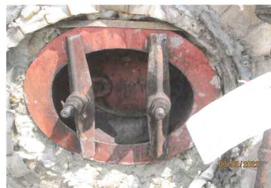
ตรวจสอบฝาMan Hole ของ Drum ต่างๆผลปกติ หม้อไอน้ำหมายเลข 2 ( HRS-02 ) บริษัทสหโคเจน (ชลบุรี) จำกัด(มหาชน) วันที่ 3 กุมภาพันธ์ 2565
