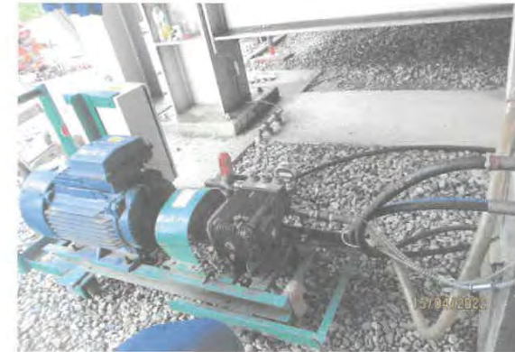
Pump ความดันสูงที่ใช้ในการอัดน้ำทดสอบ (Hydrostatic Test ) หม้อไอน้ำหมายเลข 1 ( HRSG-01 ) บริษัทสหโคเจน (ชลบุรี) จำกัด(มหาชน) วันที่ 15 เมษายน 2565
