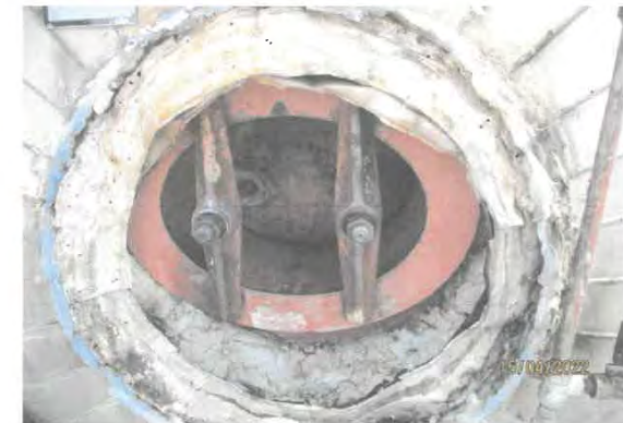
ตรวจสอบฝา Man Hole ของ Drum ต่างๆผลปกติ หม้อไอน้ำหมายเลข 1 ( HRSG-01 ) บริษัทสหโคเจน (ชลบุรี) จำกัด(มหาชน) วันที่ 15 เมษายน 2565
