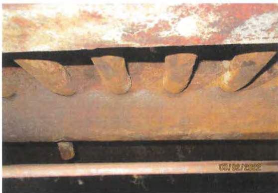
ตรวจสอบแนวเชื่อมต่อทั่วๆไปภายในหม้อน้ำ หม้อไอน้ำหมายเลข 2 ( HRS-02 ) บริษัทสหโคเจน (ชลบุรี) จำกัด(มหาชน) วันที่ 3 กุมภาพันธ์ 2565
